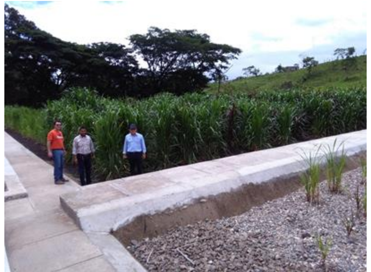
Biofilters, El Cua Treatment Plant, Nicaragua
